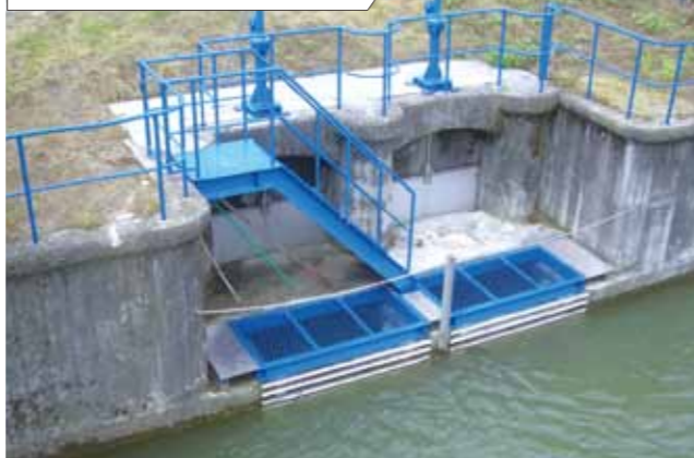
事業 (第30期生) 取水口施設補修工事
