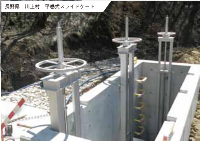
長野県 川上村 平巻式スライドゲート
