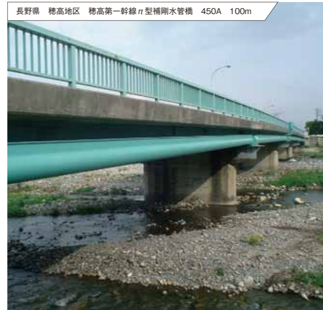
長野県 穂高地区 穂高第一幹線π型補剛水管橋 450A 100m
