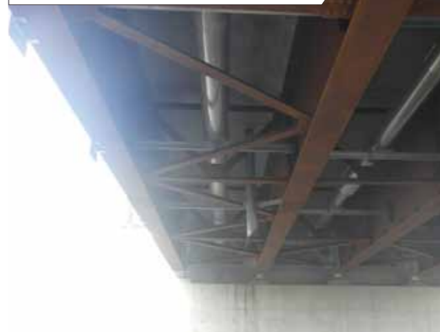
長野県 佐久市 湯川橋 400A(水道)200A/300A(下水)
