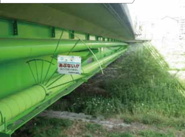
札幌市 小野津幌川橋 橋梁添架管 200A/φ300 36m
