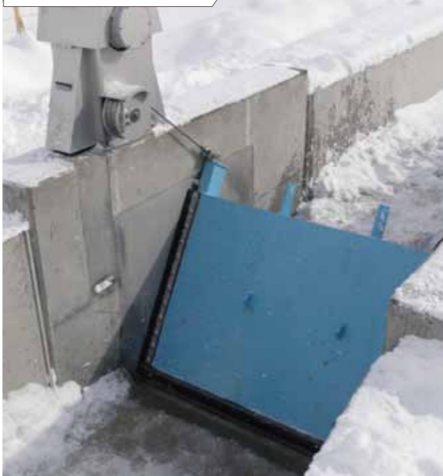
北斗市 大野平野地区 転倒ゲート
