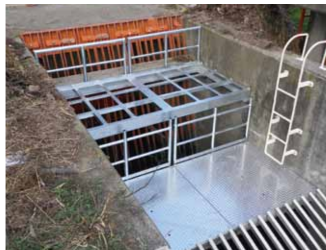
網走川土地改良区 殿 国営造成施設管理体制整備促進事業（地域防災）西幹線水路スクリーン設置工事 幅 2500×水深 1000 請負人：株式会社 新興工業
