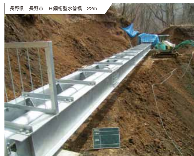
長野県 長野市 H鋼桁型水管橋 22m
