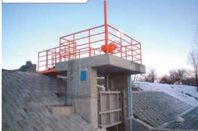
北海道 芽室町 制水門 (樋門)
