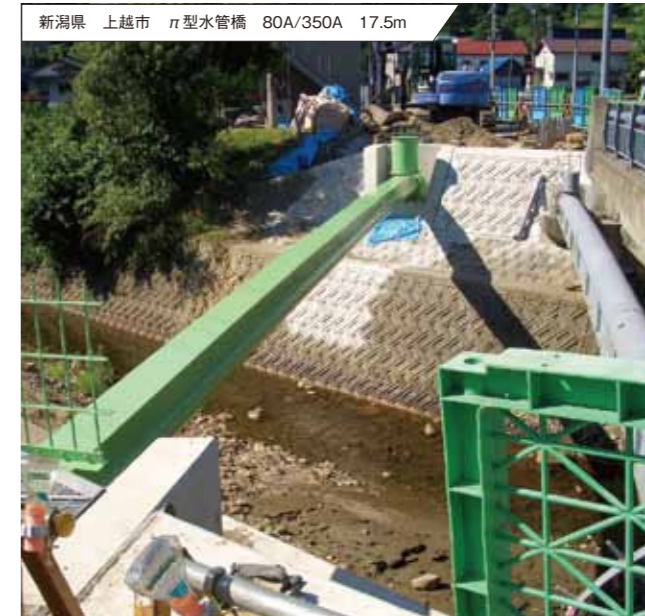
新潟県 上越市 π型水管橋 80A/350A 17.5m
