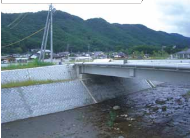
長野県 佐久市 龍岡橋 橋梁添架管 250A/φ350 23m
