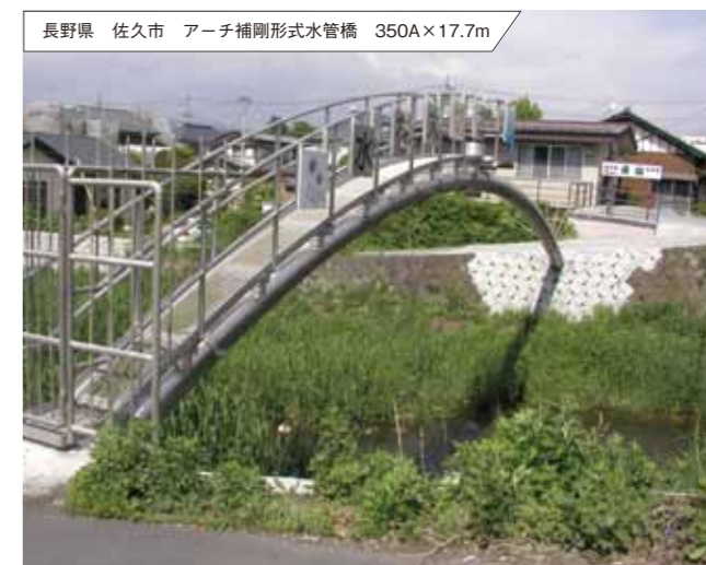
長野県 佐久市 アーチ補剛形式水管橋 350A×17.7m
